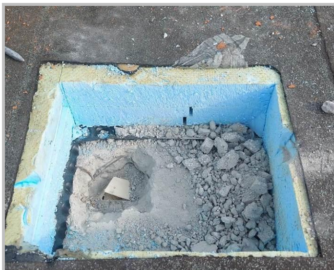
Obrázek č. 7 a 8 : Sondy do konstrukce střešního pláště
