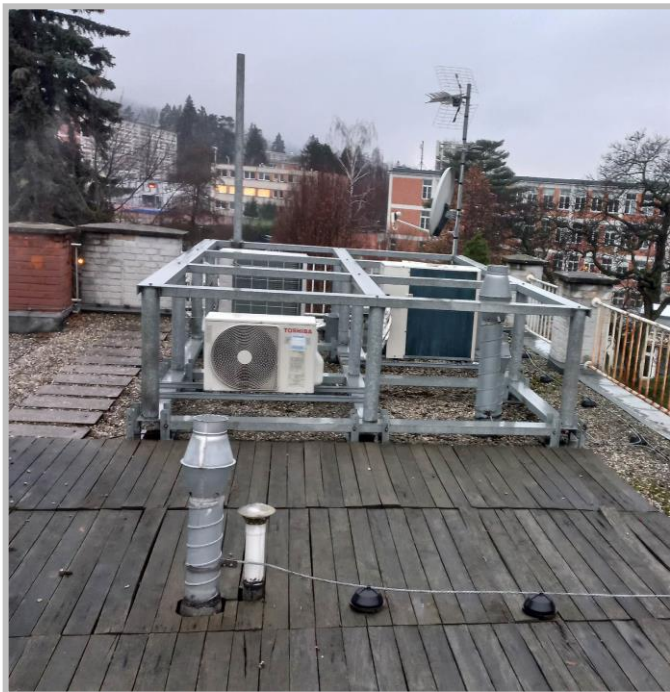
Obrázek č. 21 a 22: Ukončení odvětrání kanalizace / VZT, jímač hromosvodu
